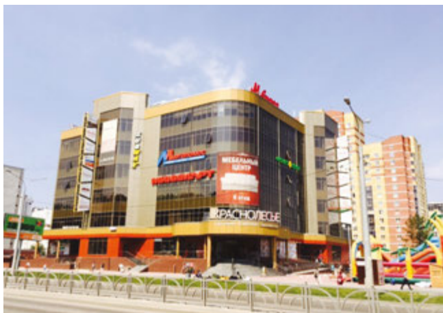
ТОРГОВЫЙ ЦЕНТР «КРАСНОЛЕСЬЕ» Екатеринбург, 700 квТ
