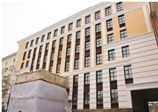
БИЗНЕС-ЦЕНТР «БАСМАНЫЙ ПАРК» Москва, 495 кВт
