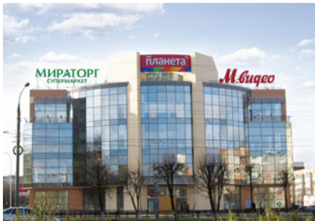
ТОРГОВЫЙ ЦЕНТР «ПЛАНЕТА» Йошкар-Ола, 836 квТ
