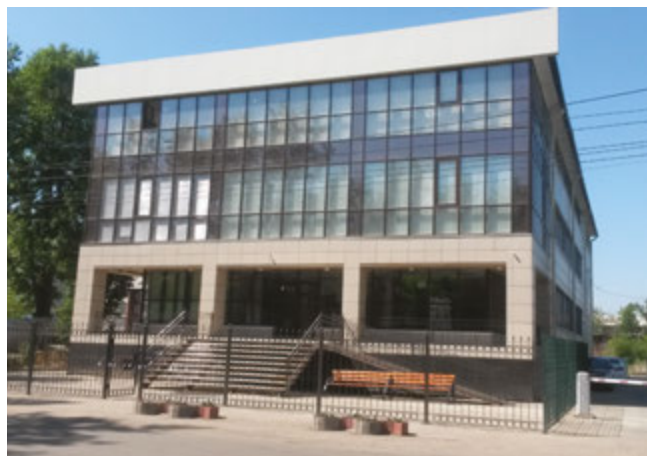
КОЛЛ-ЦЕНТР «ТЕЛЕ2» Иркутск, 300 квТ
