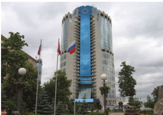
ГУП «МОСВОДОСТОК» Москва, 440 кВт
