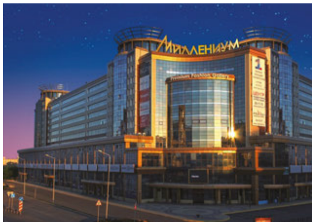
ТОРГОВЫЙ ЦЕНТР «МИЛЛЕНИУМ» Омск, 410 кВт
