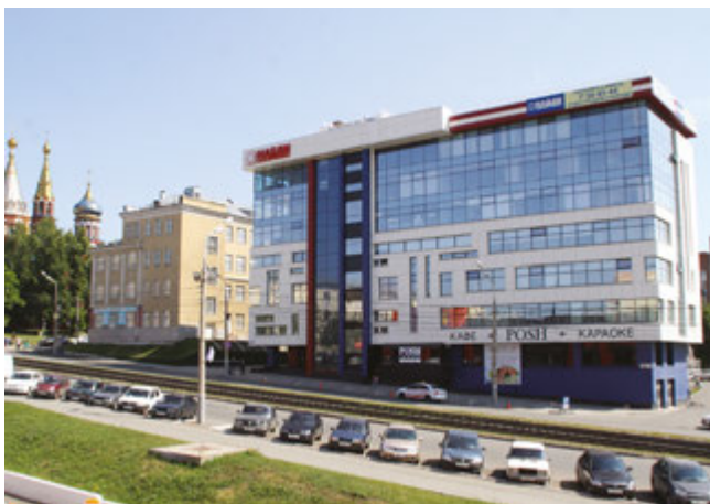
БИЗНЕС-ЦЕНТР «НАЙДИ» Ижевск, 498 кВт
