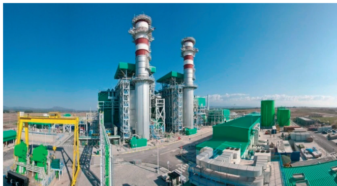
Эрзинская электростанция комбинированного цикла, г. Искендерун, Турция
