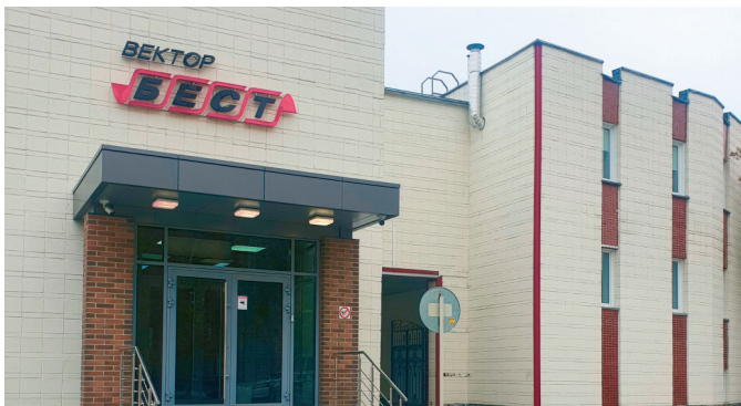
Производственный комплекс АО «Вектор Бест», Корпус 14. г. Новосибирск
