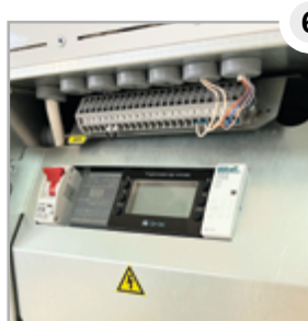
Обвязка системы автоматического управления
