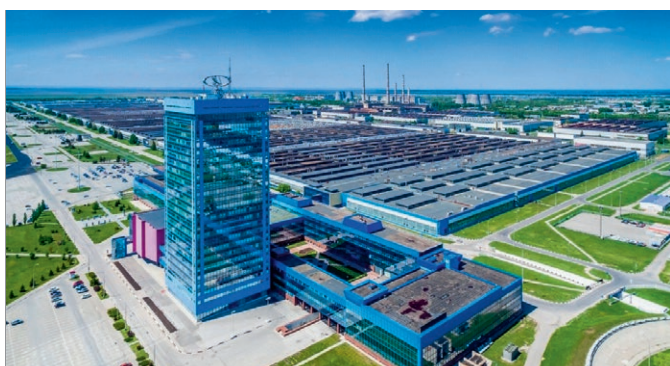
Автомобильный завод «АвтоВАЗ», г. Тольятти
