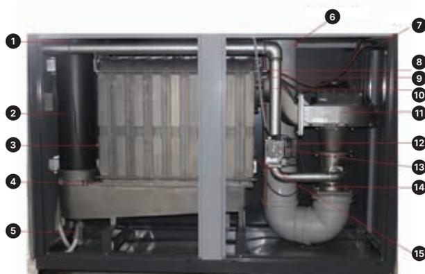
1. Датчик температуры уходящих газов
