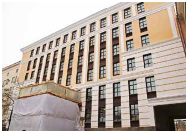
БИЗНЕС-ЦЕНТР «БАСМАНЫЙ ПАРК» Москва, 495 кВт
