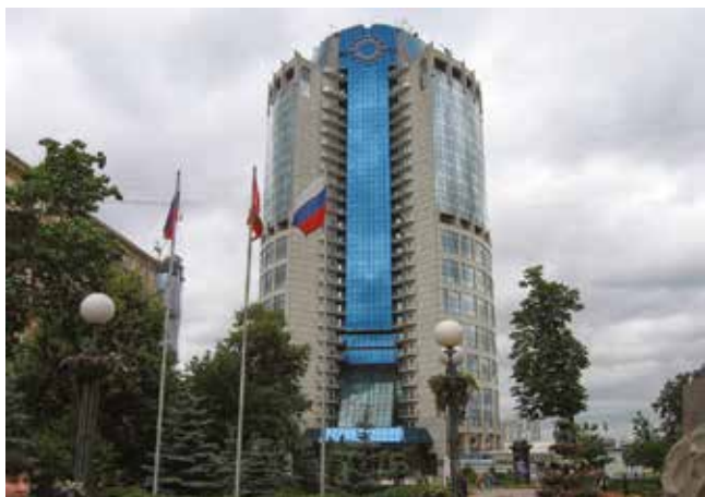
ГУП «МОСВОДОСТОК» Москва, 440 кВт
