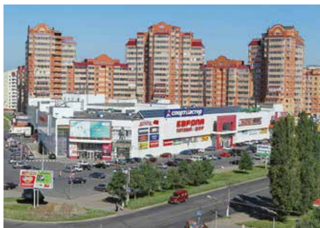
ТОРГОВЫЙ ЦЕНТР «ЕВРОПА 26» Железногорск, 320 кВт
