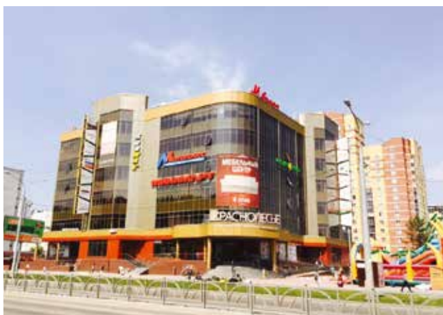
ТОРГОВЫЙ ЦЕНТР «КРАСНОЛЕСЬЕ» Екатеринбург, 700 кВт
