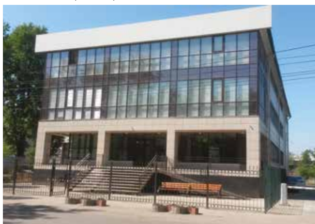
КОЛ-ЦЕНТР «ТЕЛЕ2» Иркутск, 300 кВт
