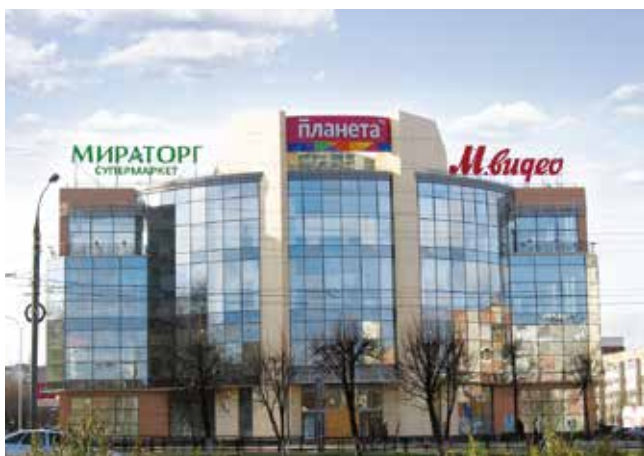
ТОРГОВЫЙ ЦЕНТР «ПЛАНЕТА» Йошкар-Ола, 836 кВт
