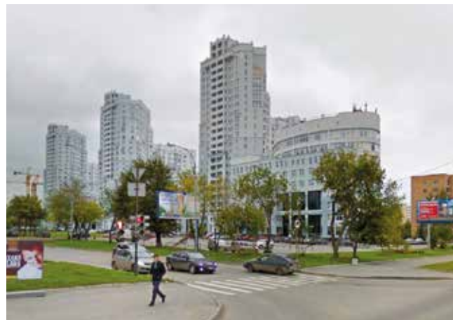
БИЗНЕС-ЦЕНТР «ТАТИЩЕВСКИЙ» Екатеринбург, 500 кВт
