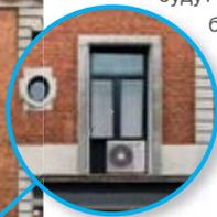
Уникальные наружные блоки с одним вентилятором (4, 5 и 6 HP) – наиболее компактные и легкие. Они специально созданы для размещения в ограниченном пространстве, например, будут совершенно незаметны на балконе или за парапетом. Для установки наружного блока не требуется специальная подъемная техника. Вся работа по установке может быть проведена двумя специалистами.
